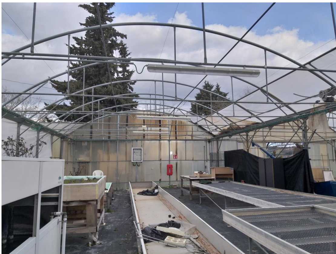
Particolare tubi che sorreggono la struttura reticolare degli archi della serra
