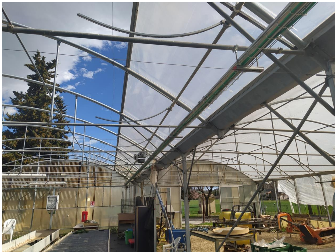
Particolare apertura motorizzata in prossimità della gronda su navata di destra
