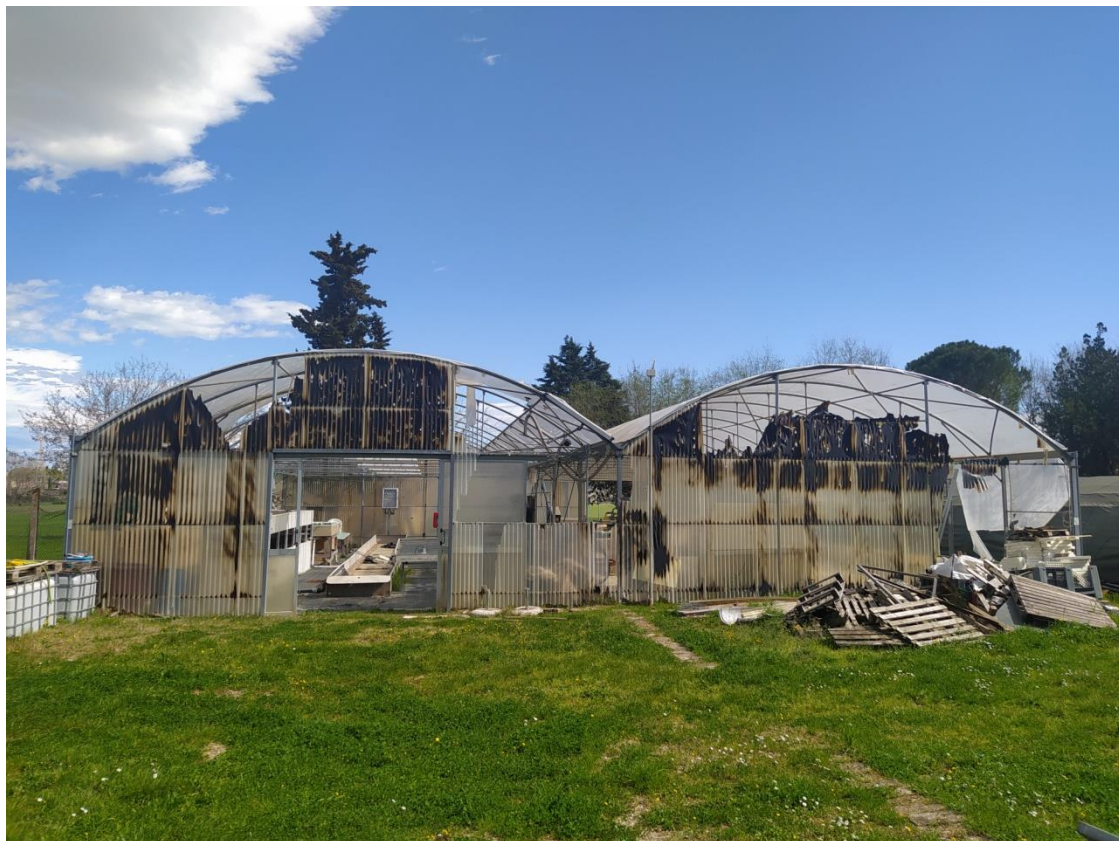
Foto prospetto Sud-Ovest
