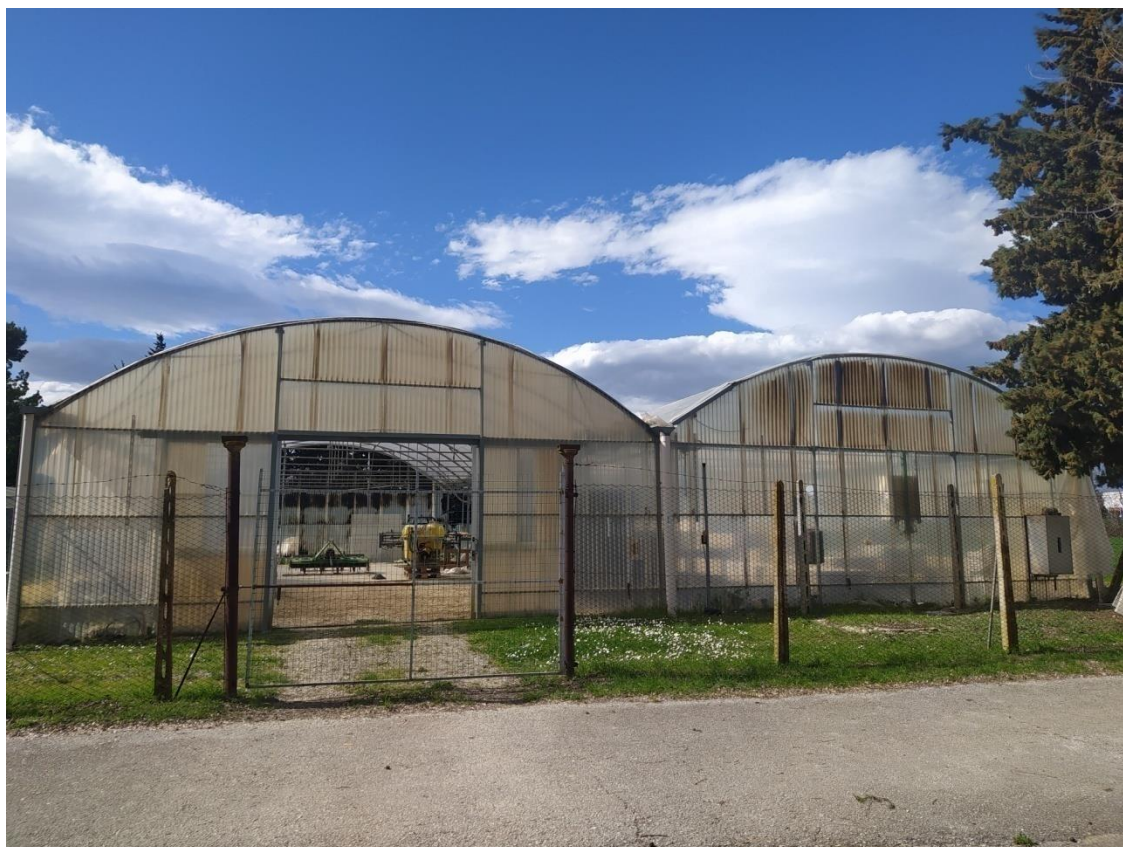
Foto prospetto Nord-Est
