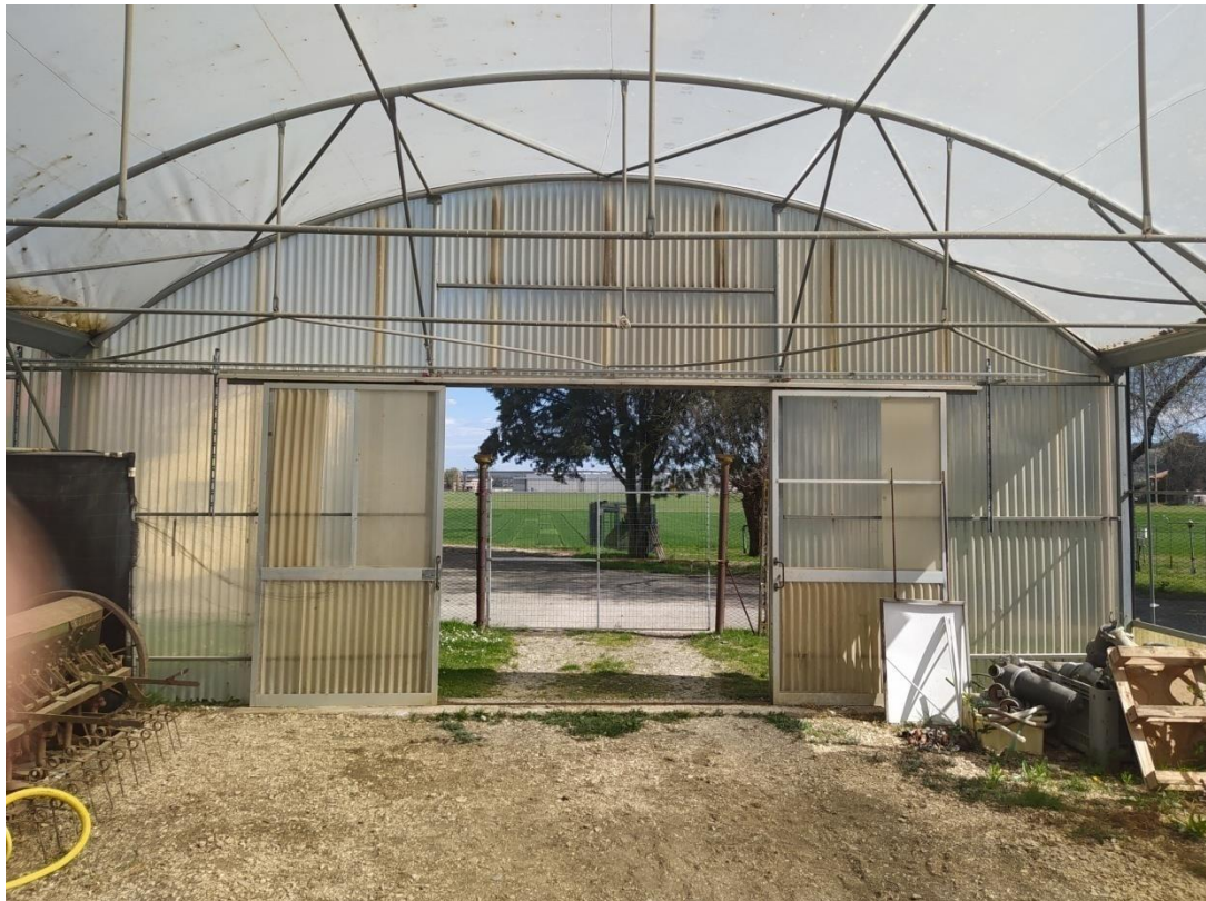
Particolare porta scorrevole a due ante su testata in policarbonato ondulato
