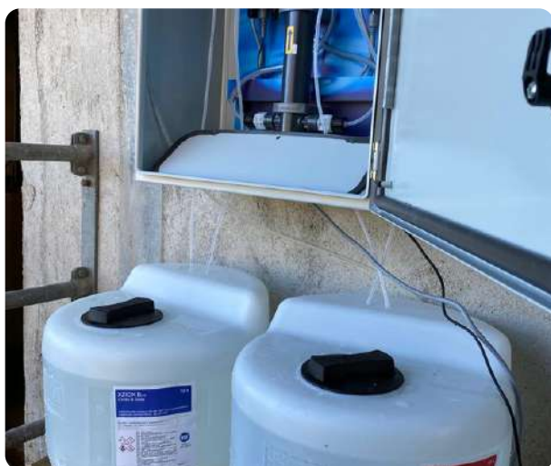
Impianto con biossido di cloro installato presso una stalla per la sanificazione dell'acqua di abbeverata.
