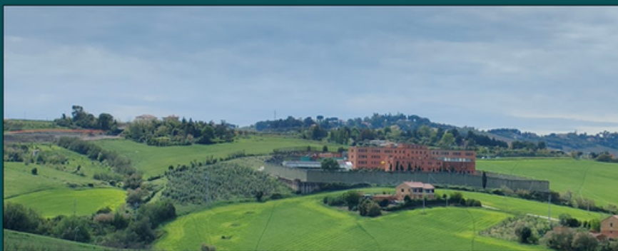
Casa di Reclusione di Barcaglione - Ancona (AN)
